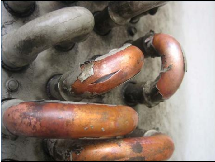
Şekil 8. Donma sonucu kuru soğutucu borularında meydana gelen tipik bir hasar [9]
