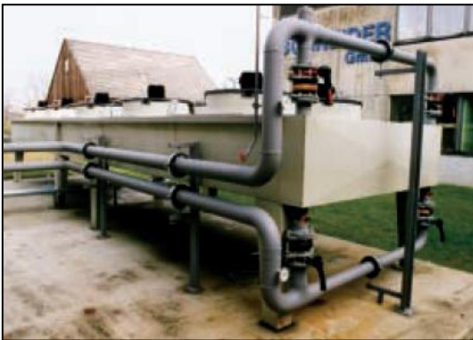
Şekil 10. Sistemde kurulu kuru soğutucu [16]
